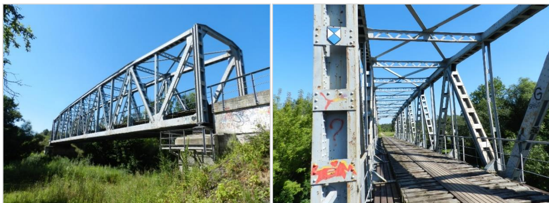
6.6.5. attēls. Dzelzeļa tilts pār Mazo Juglu
