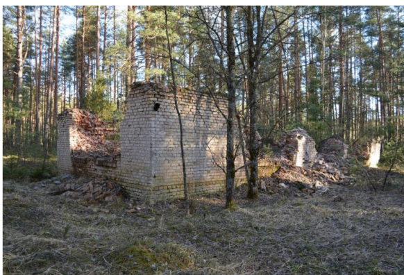
6.6.10. attēls. Celtnes, kartē atzīmēta ar Nr.10, skats dienvidaustrumu virzienā
