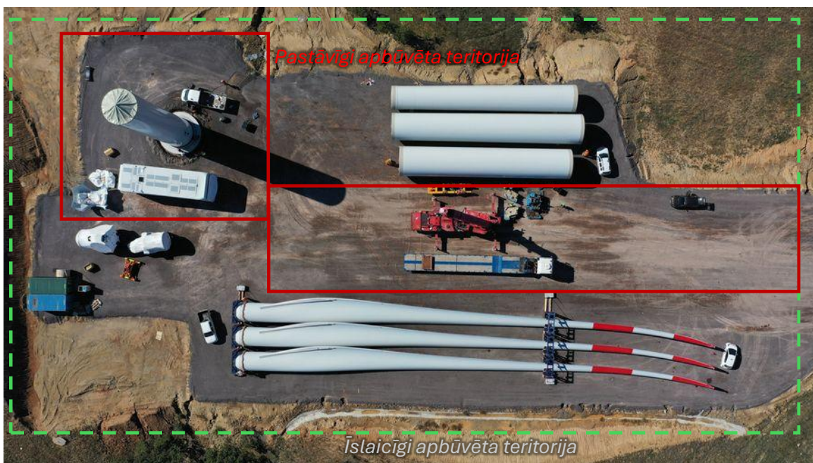
2.3.3.1. attēls. Montāžas laukuma piemērs vēja parkam Ziemeļmaķedonijā (avots: https://www.ing-grad.hr/en/what-we-do/energy-and-infrastructure/energy/wind-farm-bogoslovec-north-macedonia )
