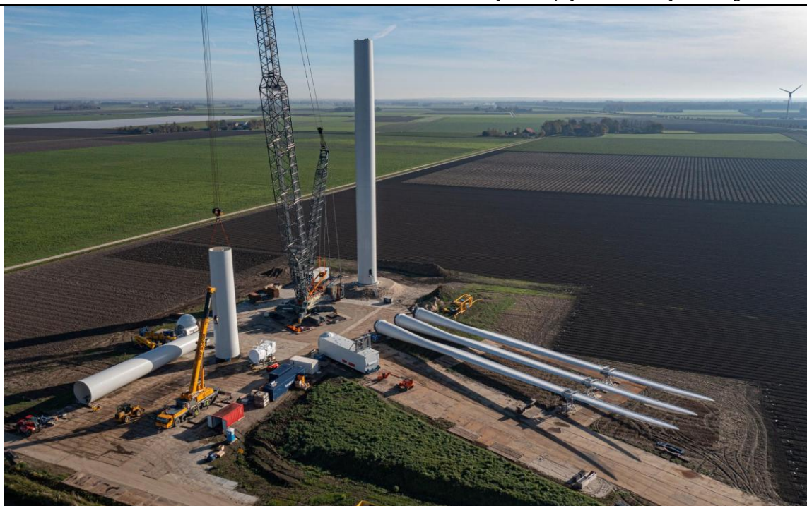
2.4.5.attēls. Montāžas laukuma elementu novietojuma piemērs 13
