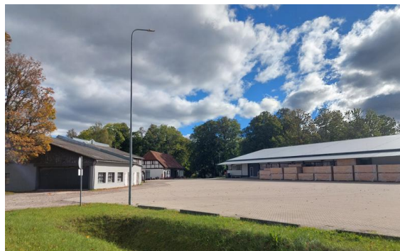
No Deksnī muižas palikusi apbūve, piemēram, klēts ēka, integrēta tehniskas apbūves zonā. Attālums līdz EPL – nepilns 1 km.
