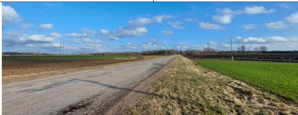
Esošā 110 kV elektrolīnija, kas šķērso ainavisko ceļu.
