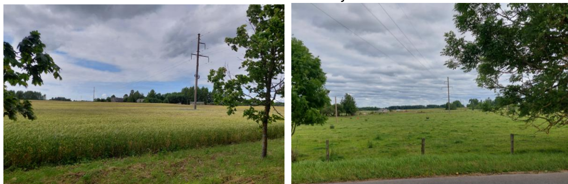
Esošās 110 kV līnijas šķērsojums.
