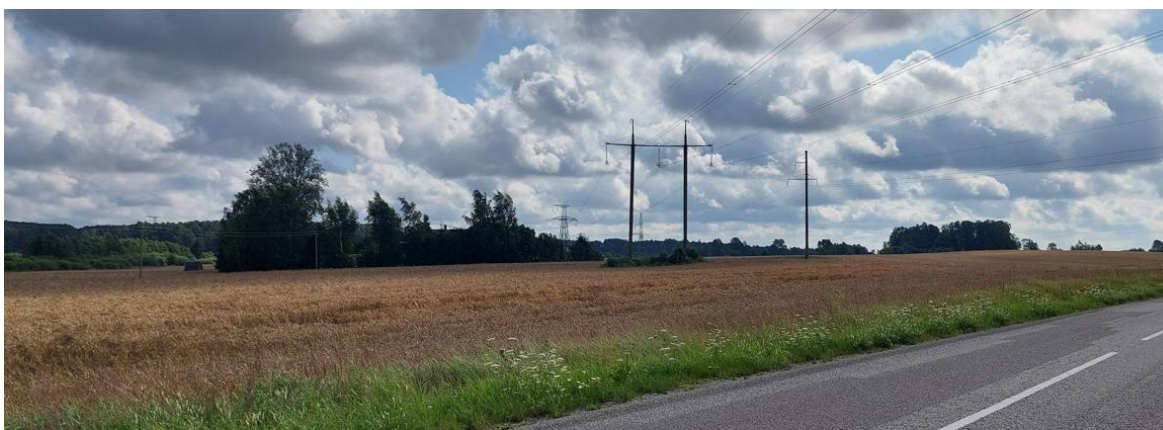
Esošā kombinētā 110/330 kV elektroliņija un 110 kV elektroliņija.
